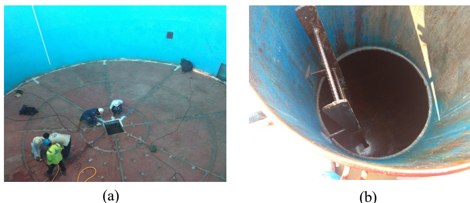
Gambar 1.1 (a) Proses Pekerjaan NDT, (b) Tangki Kapal
