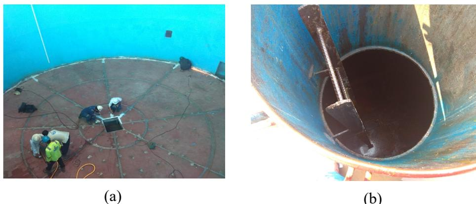
Gambar 1.1 (a) Proses Pekerjaan NDT, (b) Tangki Kapal
